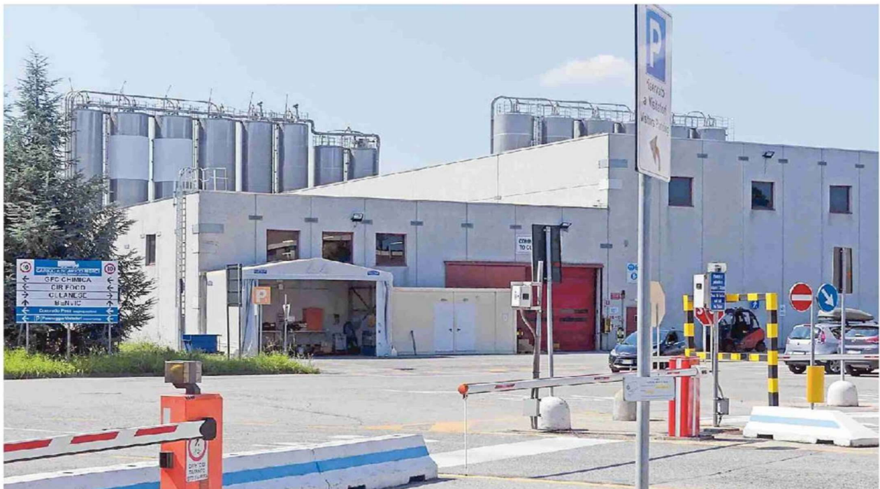
Lo stabilimento di Celanese "Marconi", da ieri di fatto passato nelle mani della "Benvic" / FOTO ANDREA ROSSETTI
