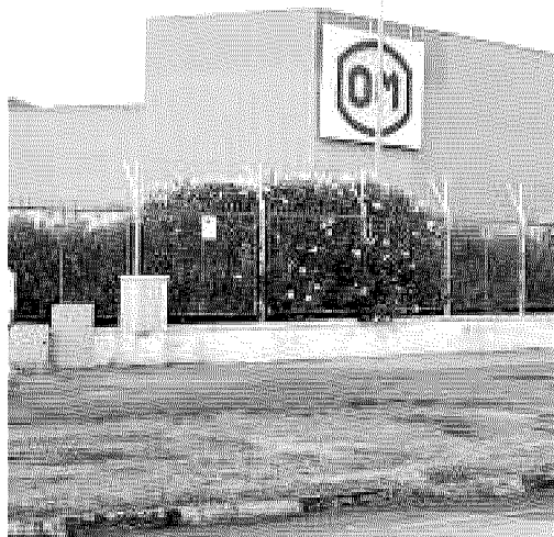
IN VENDITA Lo stabilimento della Om Carrelli elevatori nella zona industriale [foto Luca Turi]
